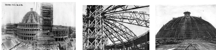
Рисунок 3. Панорама строительства, монтаж и обрешетка ферм купола.
