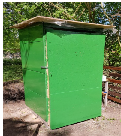
Bild 3 – Das fertige Toilettenhäuschen
