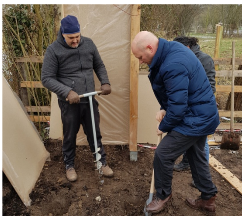
Bild 2 – Väter beim Bau der Komposttoilette
